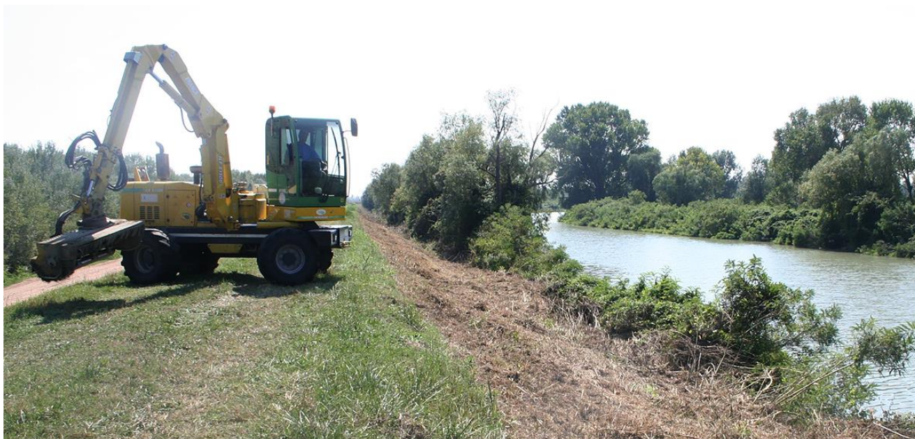
Figura 10. Decespugliamenti su Amorpha fruticosa in corpo arginale in frodo lato fiume.
